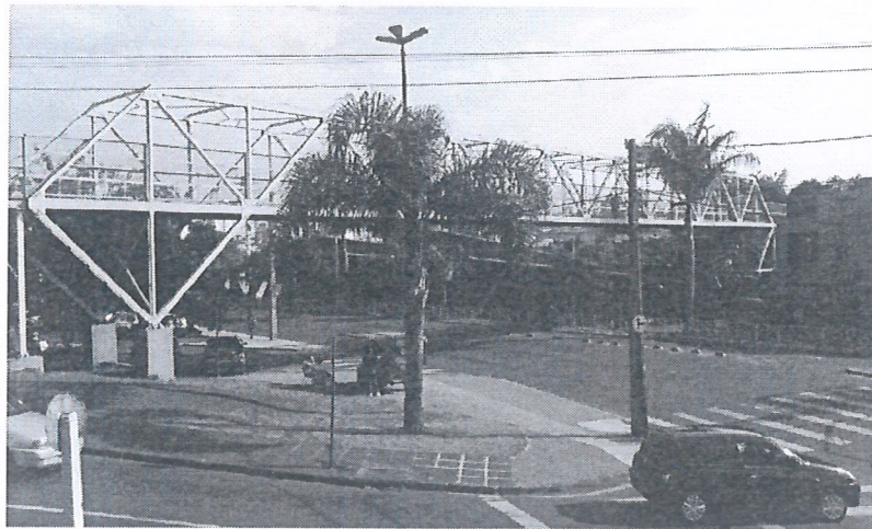
Figura 1 – foto atual da passarela, em agosto de 2016.
