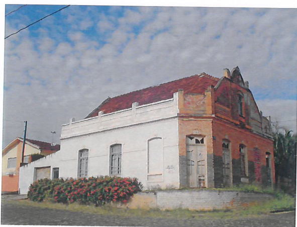
Foto 01: Vista do imóvel
