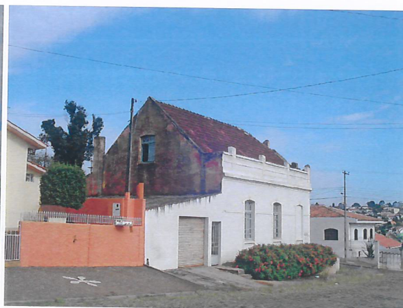
Foto 02: Anexo ao edifício tombado.
