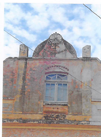
Foto 06: Detalhe da janela do sótão.
