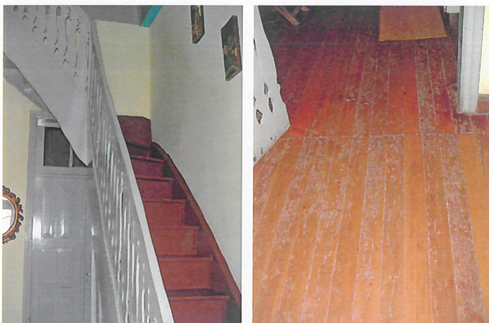
Fotos 11 e 12: Detalhe da escada de acesso ao sótão e piso em tabuado de madeira.
