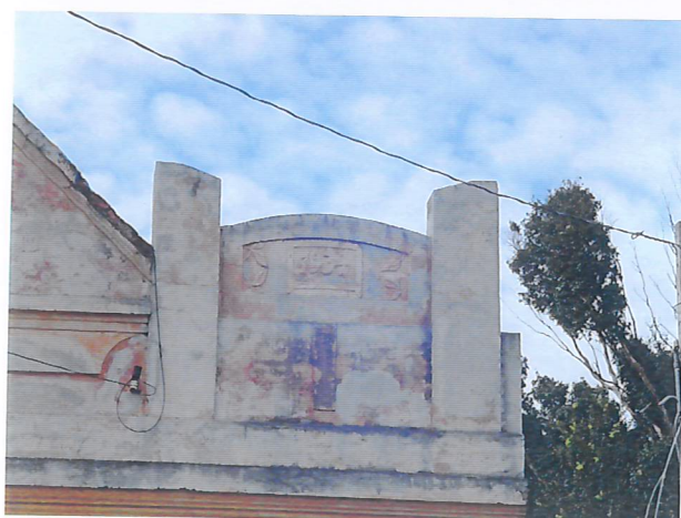
Foto 05: Inscrição na fachada principal.
