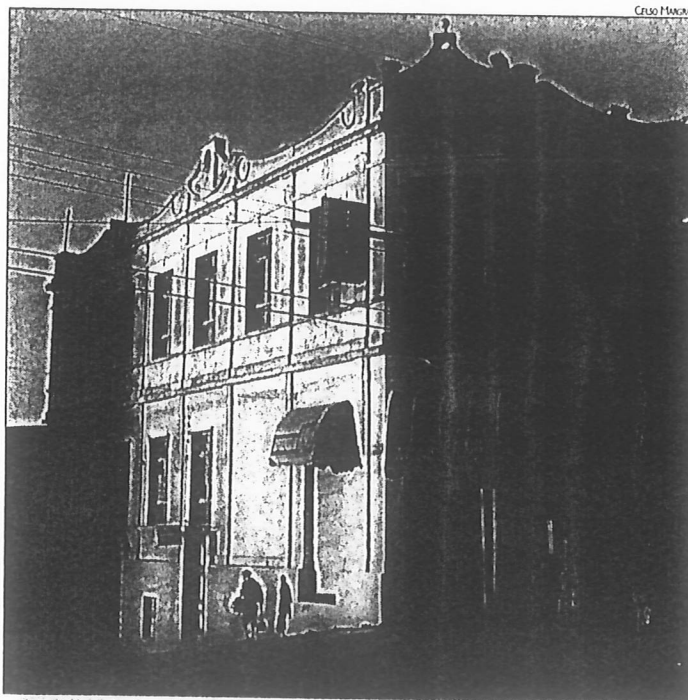
Casarão da Avenida Vicente Machado está entre os imóveis em processo de tombamento preliminar
