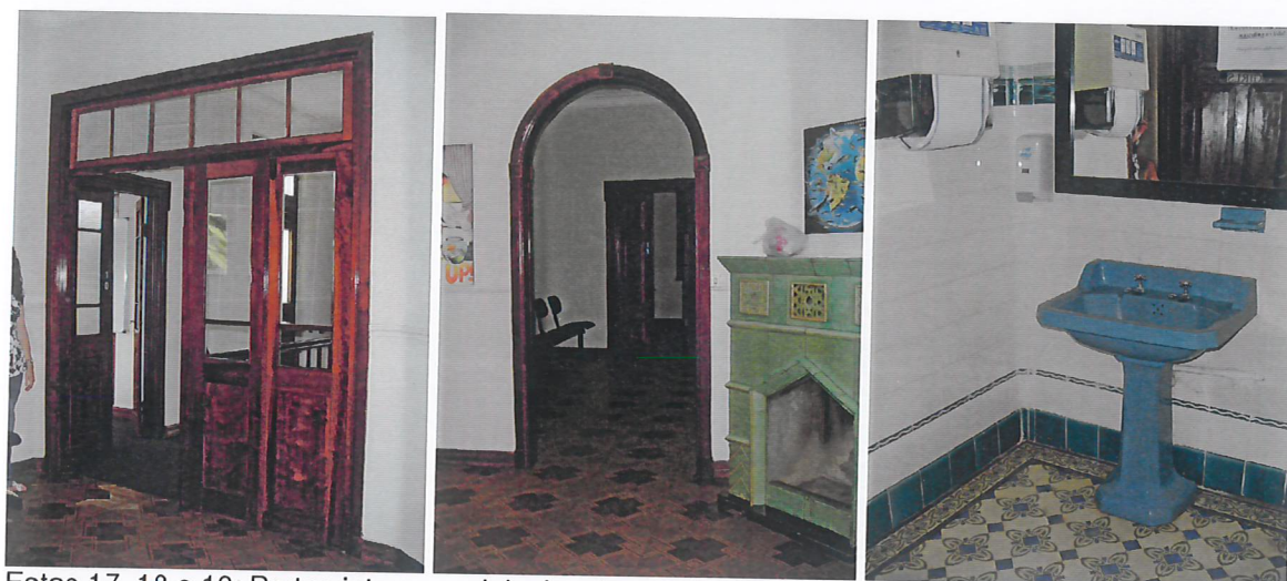
Fotos 17, 18 e 19: Portas internas originais, algumas com as folhas removidas. Instalações sanitárias originais adaptadas. Substituição de alguns azulejos, remoção dos metais e banheira originais.
