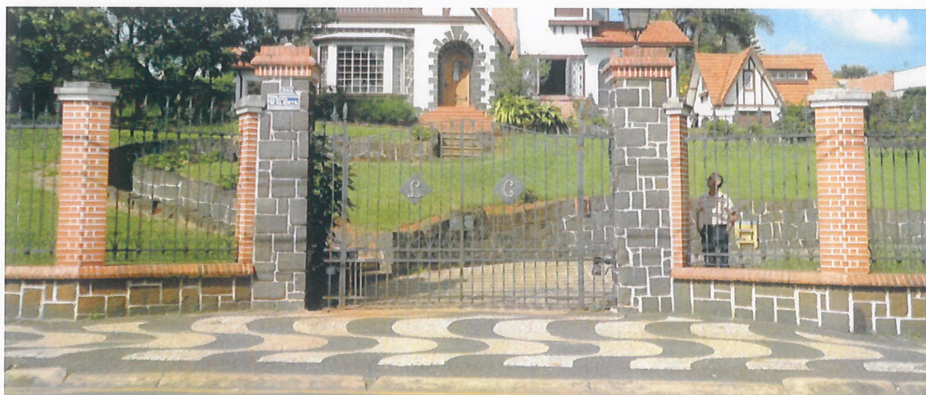
Portão com modificações em relação a planta original. 2012.
