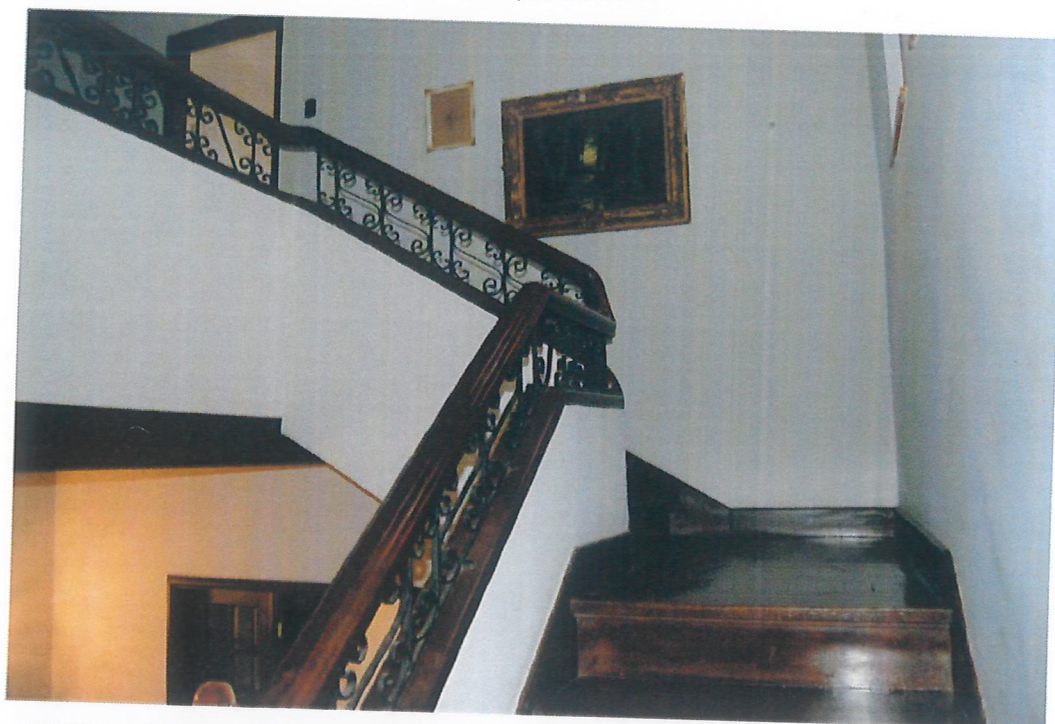
Detalhe da escada interna e corrimão entalhado em madeira e ferro. 2012.
