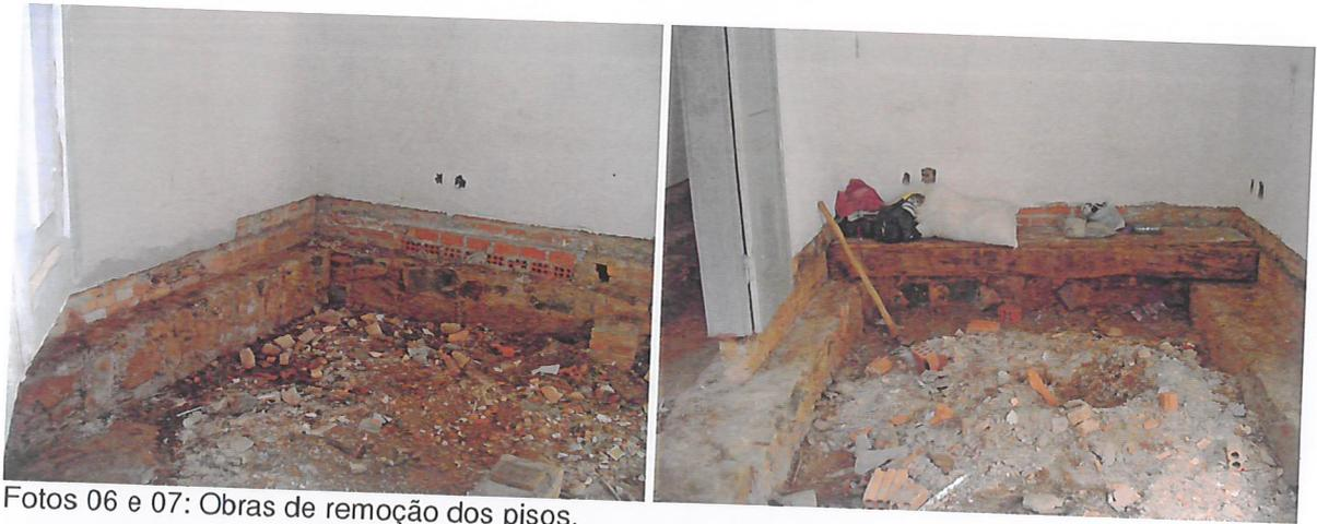
Fotos 06 e 07: Obras de remoção dos pisos.
