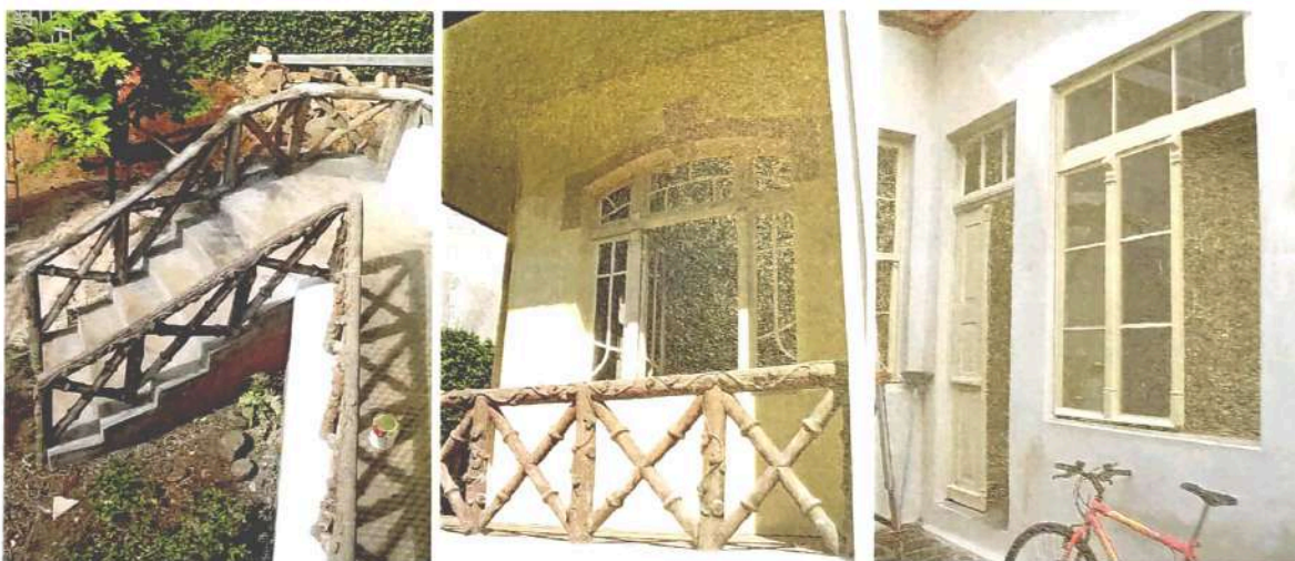
Fotos 03, 04 e 05: Detalhes da escada de acesso frontal e esquadrias em madeira dos fundos.
