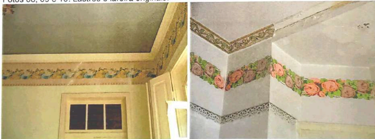
Fotos 11 e 12: Pinturas decorativas do tipo máscara presentes em todos os cômodos da casa e apliques em gesso.
