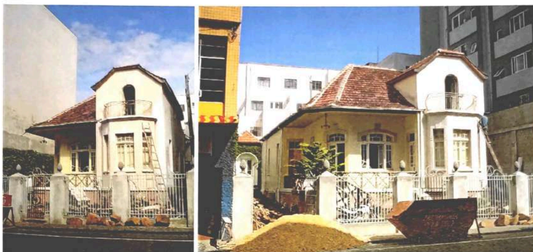
Fotos 01 e 02: Vistas gerais do edifício.
