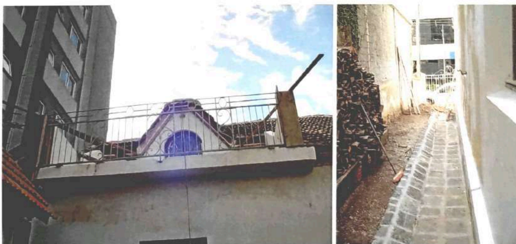
Fotos 06 e 07: Gradil do avarandado dos fundos e calçada lateral sendo reconstituída.
