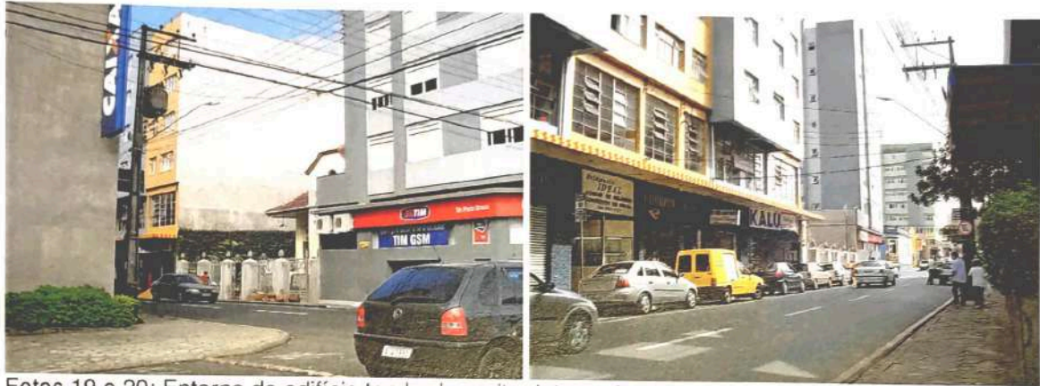
Fotos 19 e 20: Entorno do edifício tombado muito deturpado.
